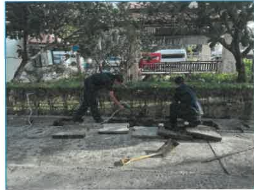
ภาพถ่ายที่ 2.2-9 การทำความสะอาดระบบระบายน้ำ
