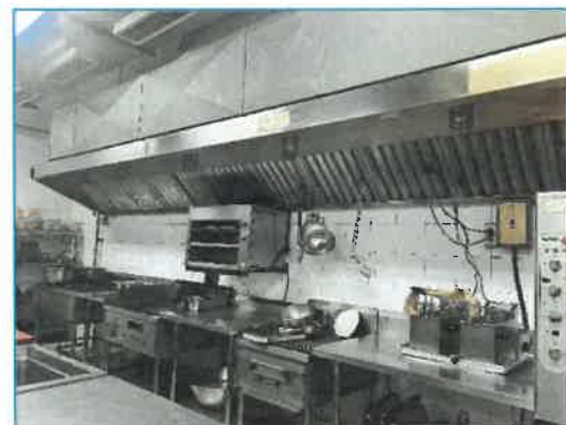
ภาพถ่ายที่ 2.2-2 พัดลมดูดอากาศ และปล่องระบายควัน
