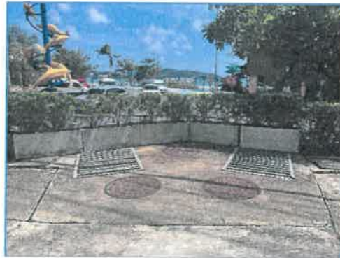
จุดเชื่อมต่อระบายน้ำทั้งจากโรงแรมลงสู่ท่อระบายน้ำทั้งหมดของเทศบาลเมืองป่าตอง
