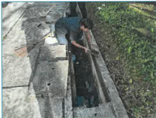
ภาพถ่ายที่ 2.2-9 การทำความสะอาดระบบระบายน้ำ
